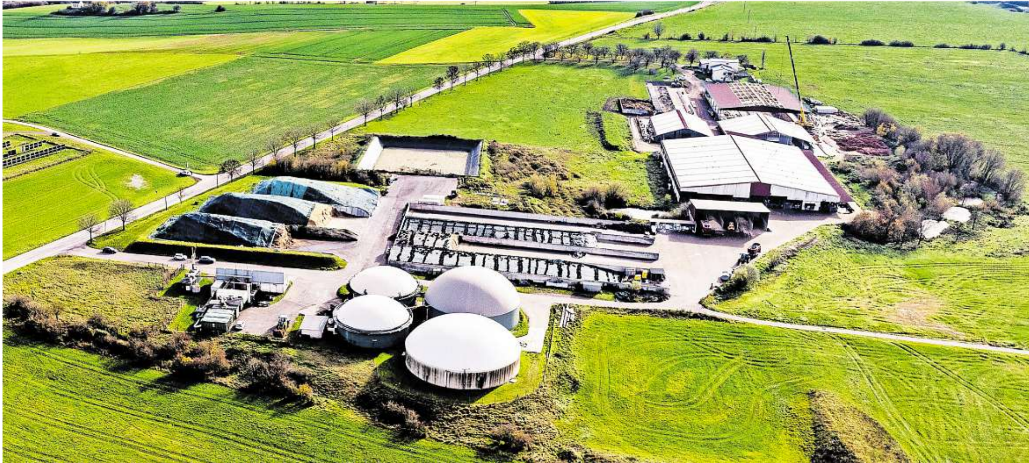
Die Biogasanlage auf der Wahleiner Platte aus der Vogelperspektive. Sie bildet das Herz des neuen Nahwärmenetzes für Losheim.
